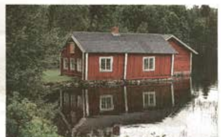
JÄRNBODEN. Järnboden höll på att åka ut sjön men med hjälp av fondpengar räddades husen. I dag håller Magnus Wetterholm poesiföreläsningar där.
